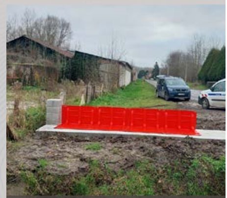
Installation d'une barrière mobile anti-inondation
